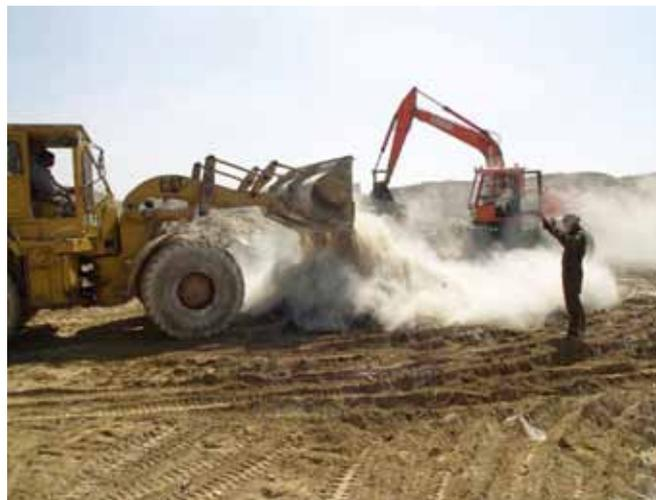
▲ 图 18：使用生石灰固化含油废物。
