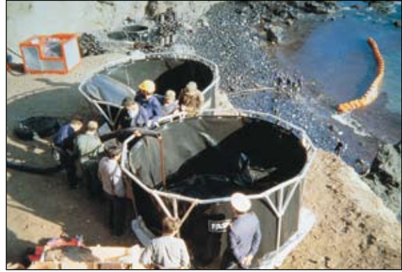
右：回收油污及油渣的临时存储及最终处理，一般是油污清理行动的重要组成部分。
