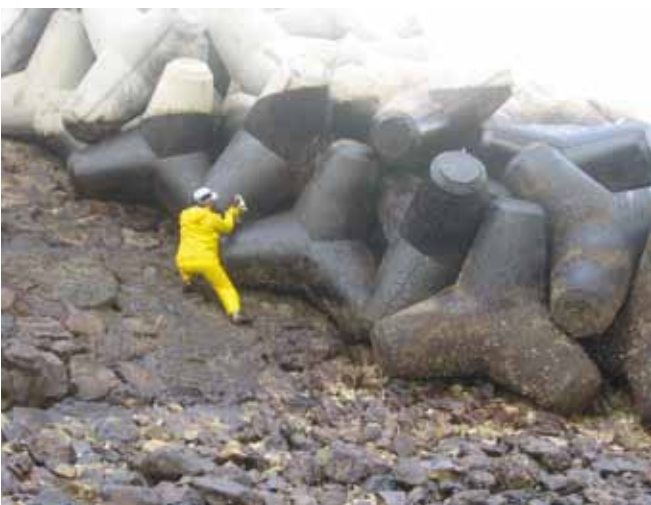
▲ 图 29：油类可能困在海防建筑之间(例如这些四脚护堤块)，从而掩盖了已到达海岸的真实油量。
