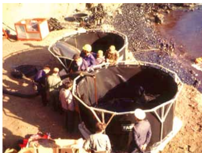
▲ 图 28: 使用撇浮装置和泵从海岸线上回收到摆放在悬崖顶部的临时储放罐中的已乳化燃油。
