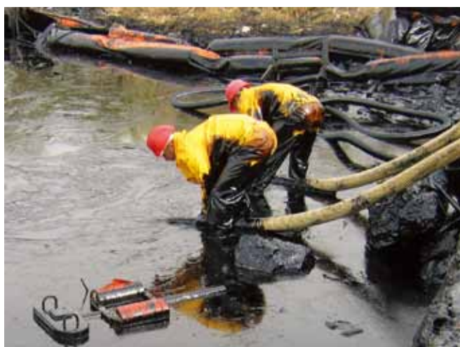
▲ 图 10：工人们正在将软管连接到直接插入油类中的真空泵。在这种情况下，拆除了所连接的小型导流坝，以使粘稠的液态油类能够流入软管中，但可能会因此而导致附连水增加。
