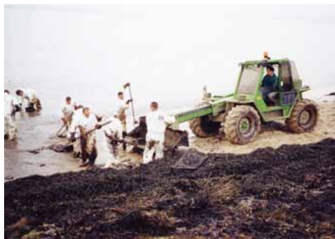
▲ 图 8：人工将油类及沾油海草清除到一个可伸缩的挖斗中。采取这种方法进行清理时可以选择含油物质而不选干净的物质，从而最大限度地减少了废物量。
