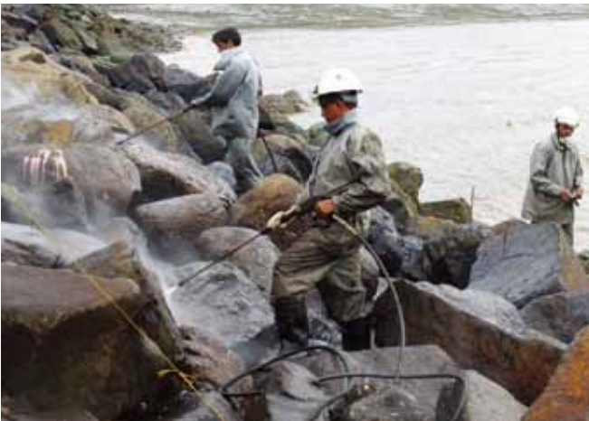
▲ 图 32：使用高压清洗装置清洗抛石。
