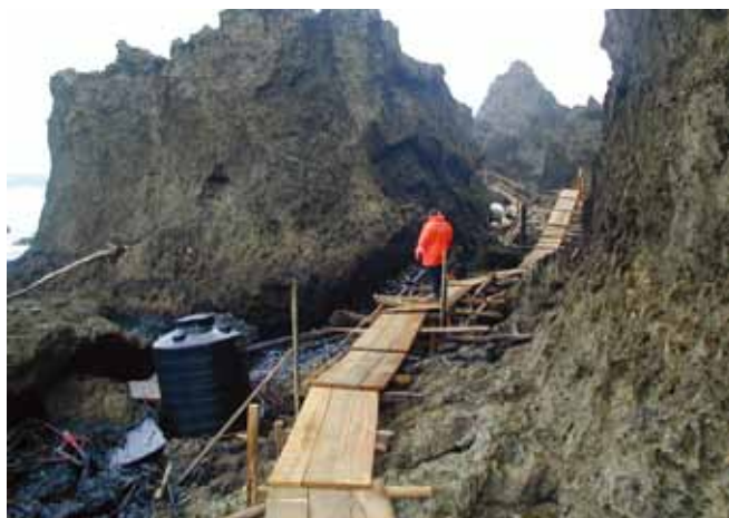
▲ 图 35：为了最大限度地减少工人在多岩石海岸线上作业时所面临的危险，可以搭建临时的过道。
