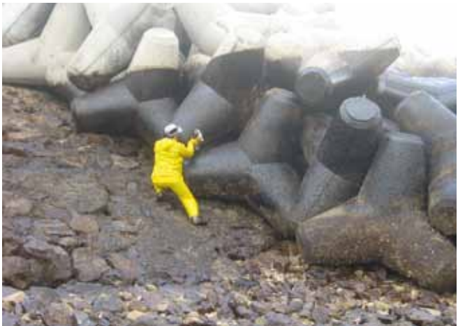
▲ 图 33：沾油四脚护堤块的清理很成问题，因为很难接触到这种建筑内的油类。
