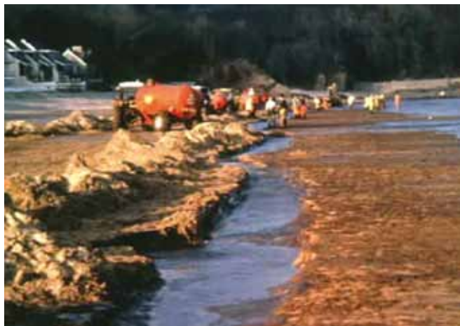
▲ 图 4：农用油罐车正在回收已被推送和冲入沟渠中的油类。
