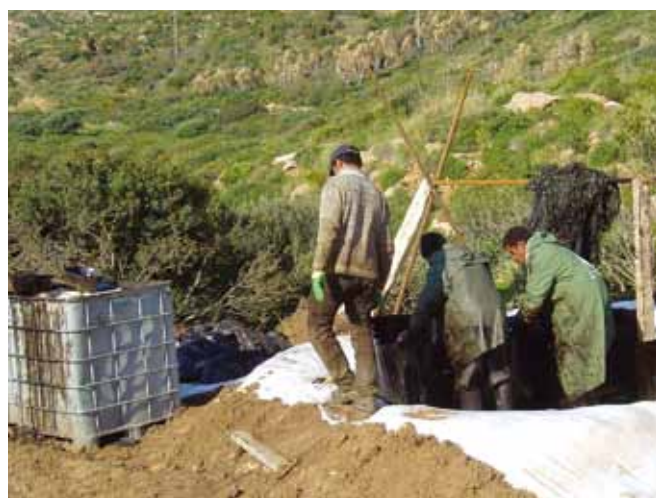
▲ 图 16：回收的溢油吸收丝团悬挂在柱子上，以让油流入容器中，从而最大限度减少废物中的游离油量。
