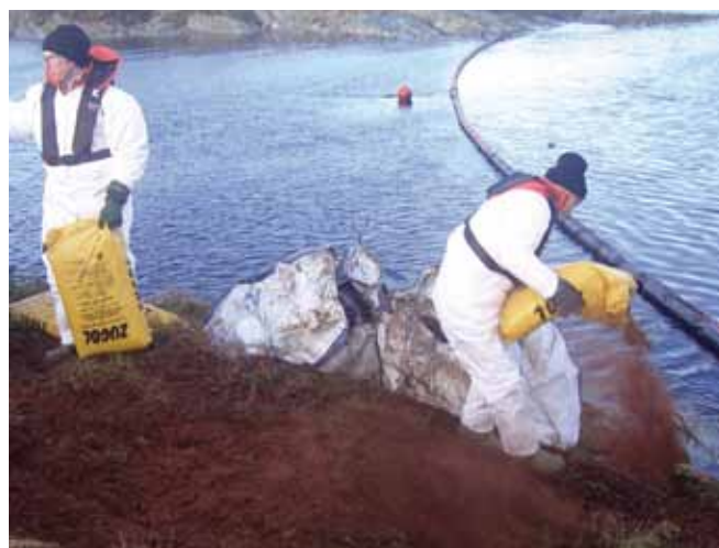
▲ 图 10：有机微粒吸油材料（如泥煤或树皮）可以用于对野生动物（如企鹅和海豹）非常重要的多岩石海岸，以最大限度减少这些动物上岸时皮毛和羽毛所受的污染。
