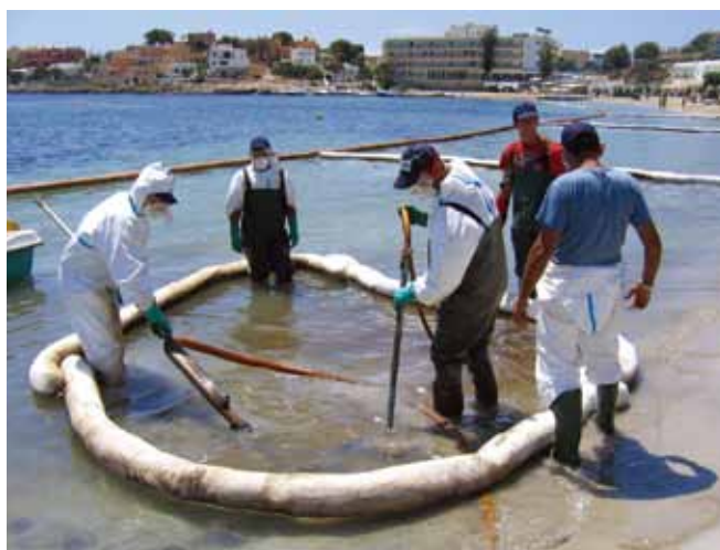
▲ 图 1：用于在冲洗作业期间收集油类的聚丙烯吸油浮木档栅。
